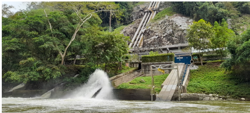
Pequeña central hidroeléctrica. Foto tomada por Denisse Roca-Servat
